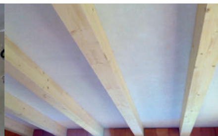
Foto 3: Desky OSB Firestop jako dřevěný záklop a podhledová vrstva. Obrázek před tmelněním spár a aplikací interiérového nátěru.
