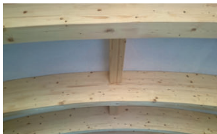
Foto 1: Střešní konstrukce - Desky OSB Firestop jako podhledová vrstva, spáry přetmeleny Firestop basic tmelem. Obrázek je před aplikací interiérového nátěru.
