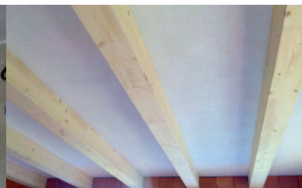
Foto 3: Desky OSB Firestop jako dřevěný záklop a podhledová vrstva. Obrázek před tmelněním spár a aplikací interiérového nátěru.
