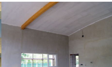
Foto 2: Desky OSB Firestop jako podhledová vrstva, spáry přetmeleny Firestop basic tmelem. Obrázek je před aplikací interiérového nátěru.
