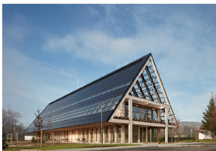
KLOBOUCKÁ LESNÍ – ADMINISTRATIVNÍ BUDOVA Administrativní budova Kloboucká lesní s.r.o. www.klobouckalesni.cz
