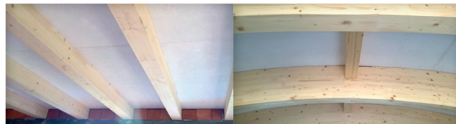
Foto 1: Střešní konstrukce – Desky OSB Firestop jako podhledová vrstva, spáry přetmeleny Firestop basic tmelem. Obrázek je před aplikací interiérového nátěru.
