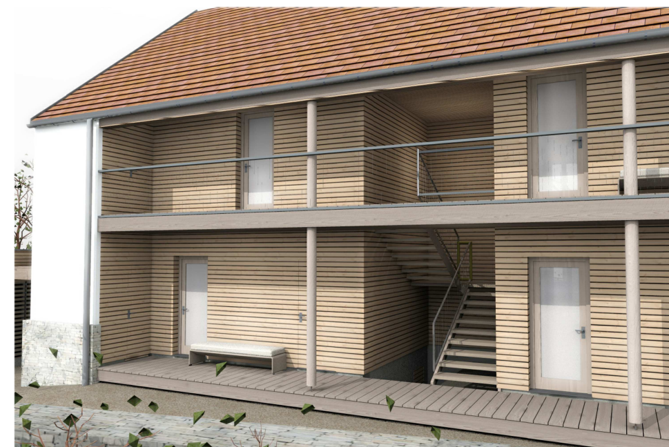
POHLED NA SCHODIŠTĚ lehké zábradlí pavlače ze sítě z ocelových lanek a sloupy z rostlého dřeva
